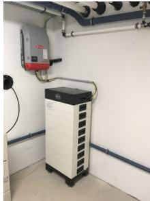
Die Batterie zur PV-Anlage speichert die Strommenge die nicht direkt gebraucht wird
